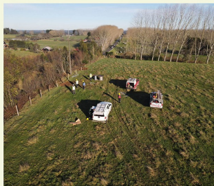
En esta primera etapa se está llevando a cabo el recambio de 3 kilómetros de conductor eléctrico, de un total de 8,5 kilómetros planificados, con una inversión de $300 millones.
