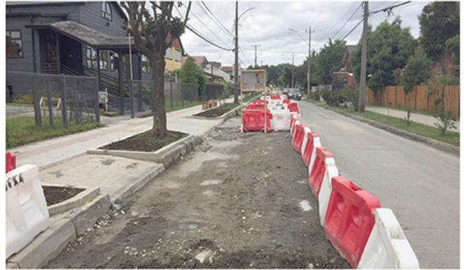
consisten en pavimentación de calzada en hormigón y asfalto, sello de juntas y reemplazo de capa de material granular. También incorpora demarcación y repintado de cruces peatonales y señalética de tránsito en 148 cruces peatonales.
