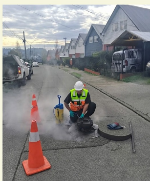
Las inspecciones se realizarán entre las 09:30 y las 18:00 horas mediante la aplicación de pruebas de humo, procedimiento que permite identificar de manera rápida y efectiva la existencia de conexiones irregulares.
