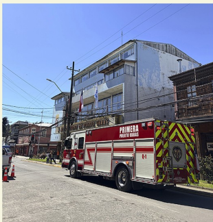
El amago de incendio se habría provocado por trabajos de soldadura. ¿Y si nos dejamos de preguntar
